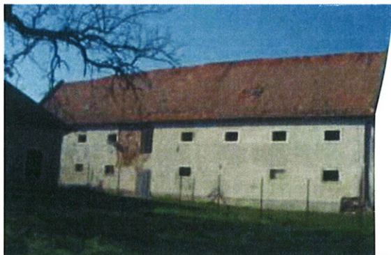
Obr. S1 – Celkový pohľad na objekt sýpky z východu
