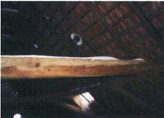
Obr. S57 – Zasnežená rozpera
