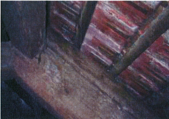
Obr. S59 – Odhnutá horná časť ležiacej stoly
