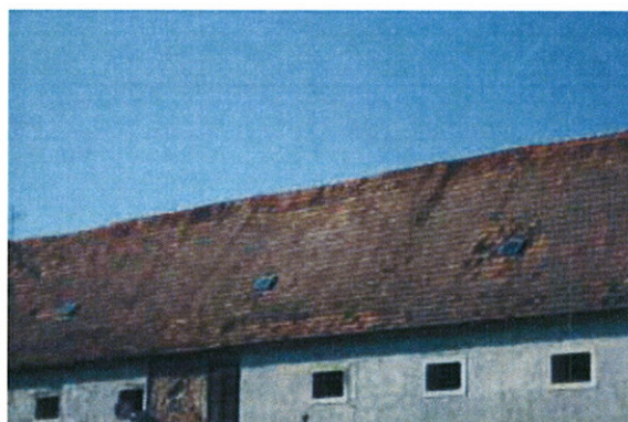
Obr. S50 – Vonkajší pohľad na krytinu
