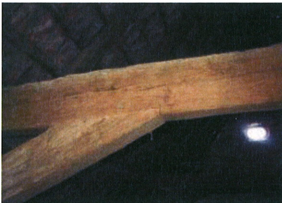
Obr. S55 – Poškodenie ležiacej stoly hmyzom
